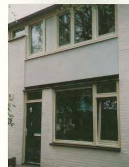
detail aangebracht profiel
