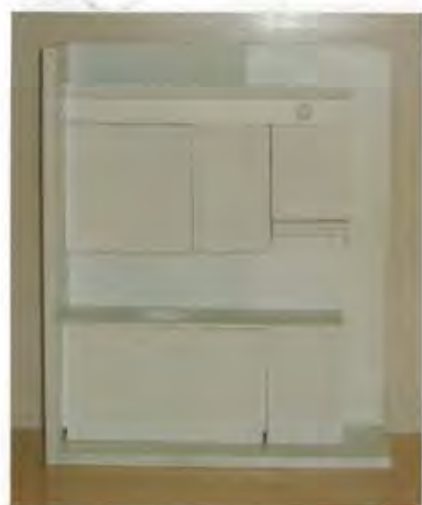
Het monteren begint met een ophangrail waaraan zowel kastjes als installaties (cv-ketel) opgehangen worden. De maatvoering van de keuken staat nu vast.
