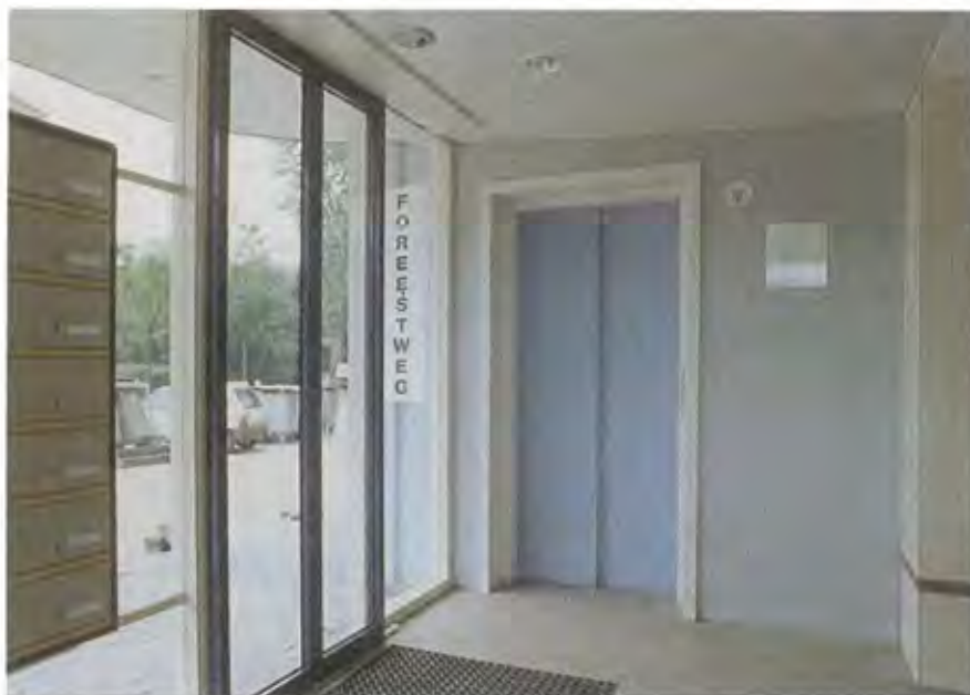
In het trappenhuis is een nieuwe lift geïnstalleerd die op elke verdieping stopt, dit in tegenstelling tot de bestaande liften die op de even of oneven verdieping een stop maken.
