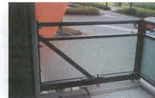
Balkons in oude en nieuwe situatie. Voor blok 5 zijn de balkons over de gehele breedte met circa een meter vergroot. De ophanging en afscheiding zijn in één geheel samengebracht, afgewerkt met nieuwe balkonhekken en schilderwerk.
