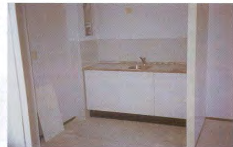
De keuken heeft geen verstelbaar aanrecht, maar de kastjes onder het aanrecht zijn wel ingeruild voor laden
