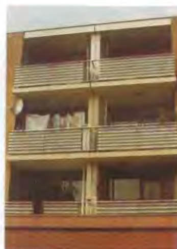
De balkons werden voorzien van nieuwe hekken. Deze geperforeerde platen omsluiten het hele balkon. In de oude situatie waren zijkant en verbinding tussen twee balkons gemaakt van een spijlenhek.
