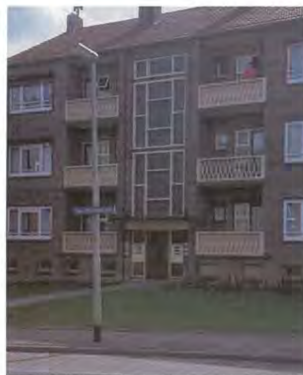
De balkonhekken met een groot wafelmotief van betonnen elementen zijn vervangen door meer eigentijdse geperforeerde staalplaten.
