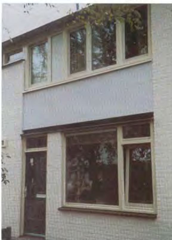
De bestaande gevelbekledingen van rode en groene golfplaten is vervangen door een buitenisolatie. Deze is afgewerkt met een stuc laag. De kleur van de stuc laag varieert per kwadrant van crèmegeel tot middengrijs.
