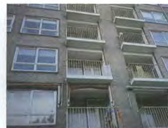
Waar nodig zijn de kozijnen aan de galerij gerepareerd en is op de gevels aan de galerijen een buiten-isolatie met kleur aangebracht.
