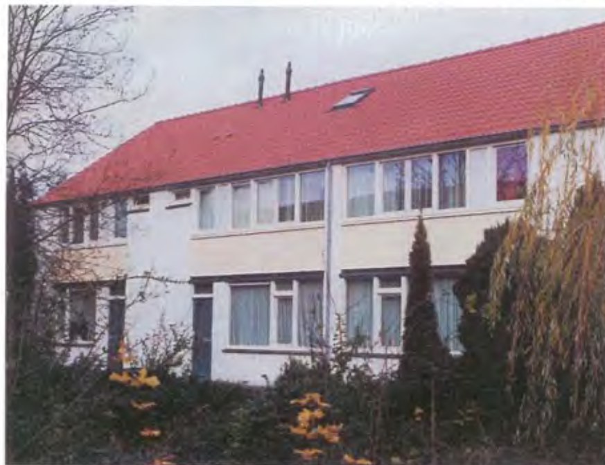
De woningen in de kwadranten 1 en 4 zijn uitgerust met dakpannen in de kleur terracotta, de gevelbekleding in kwadrant 4 werd licht crèmegeel, en de voordeuren kregen een blauwgroen verfje.
