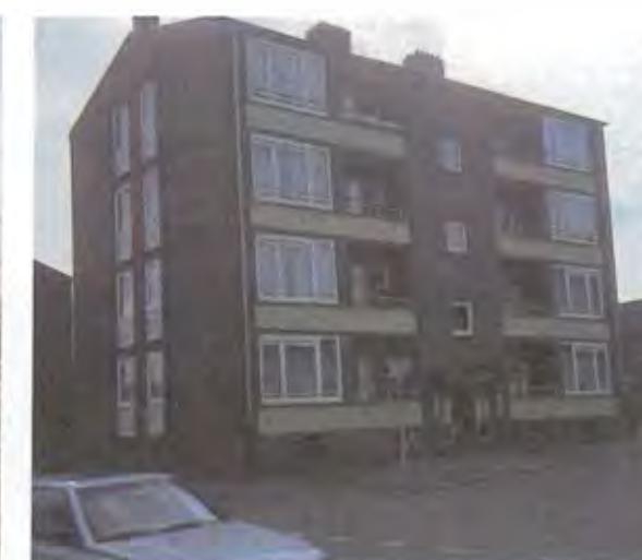
Slecht metselwerk, dichte spouwen en zwakke voegen vormden te veel mankementen om de bestaande buitengevel op te knappen. Om de schades in het metselwerk weg te werken is een buitengevelisolatie aangebracht. Op deze wijze behoren koudebruggen als gevolg van de slechte gevel tot het verleden. Elk gebouw is afgewerkt in een eigen kleur.
