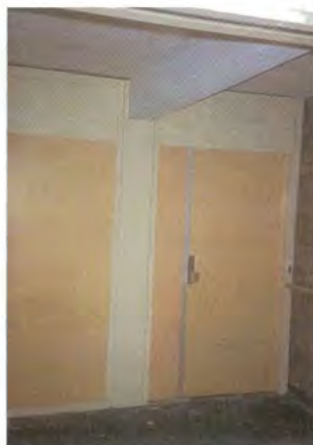
De nieuwe toegangsdeuren hebben een extra paneel waardoor het binnenrijden van ziekenhuisbedden geen problemen oplevert
