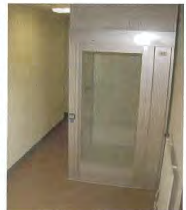
De lift staat op de plek waar voorheen de trap was gesitueerd. De doorgang naast de lift leidt naar de woningen, die aan beide zijden van de portiek liggen.
