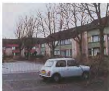
De bestaande gevelbekledingen van rode en groene golfplaten is vervangen door een buitenisolatie. Deze is afgewerkt met een stuc laag. De kleur van de stuc laag varieert per kwadrant van crèmegeel tot middengrijs.
