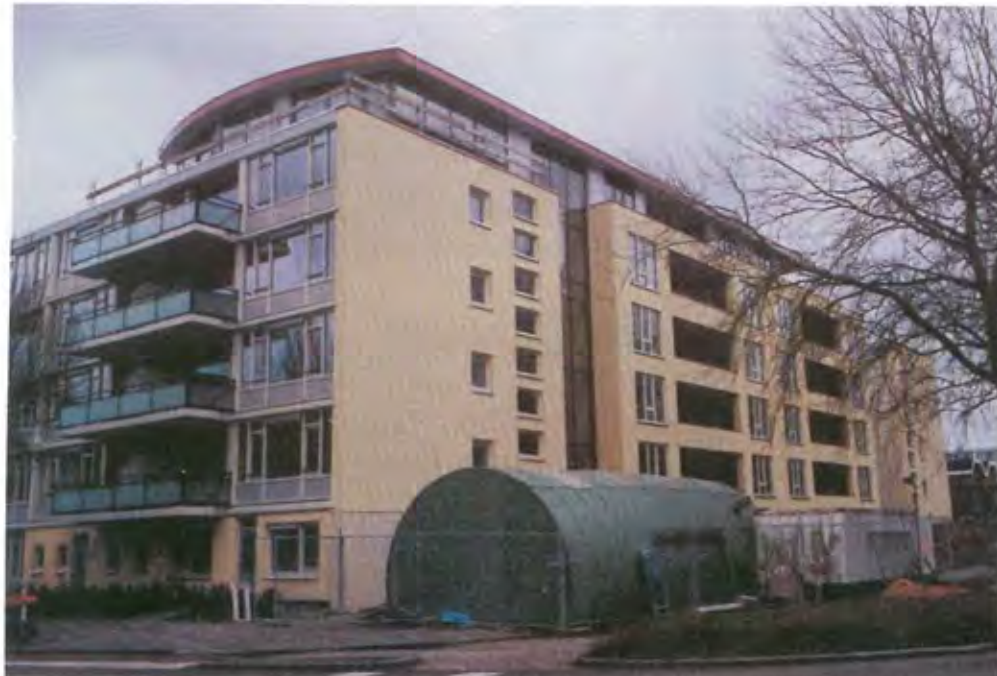
Oud en nieuw ontmoeten elkaar; het bestaande blok 5 en het nieuw gebouwde blok D met hun gemeenschappelijk trappenhuis. Boven op blok 5 het penthouse dat de 24 e nieuwbouwwoning vormt.
