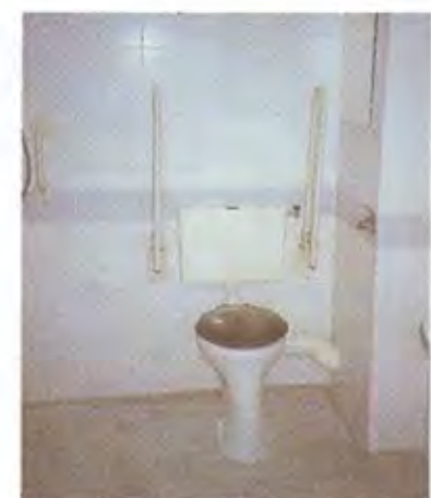
De badkamers zijn ruim en geschikt voor rolstoelers en voorzien van een vast douchezitje en beugels bij de toiletspot
