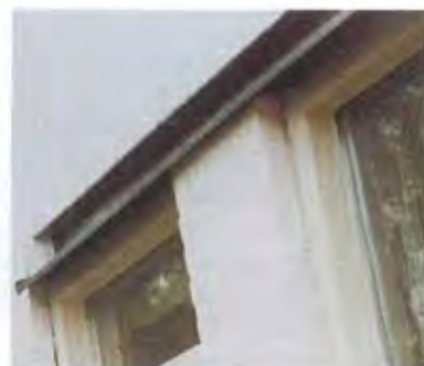
Als accent tussen de gevelbekleding en het onderliggende deel van de gevel werd een aluminium strip gemonteerd. Deze strip doet tevens dienst als waterslag.
