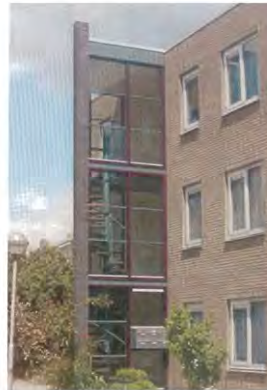
De toegang tot de woningen is nu een markant punt in de gevelwand. In de oude situatie was de herkenbaarheid beperkt tot een klein luifeltje met een aantal smalle ramen die het portiek verlichtten.
