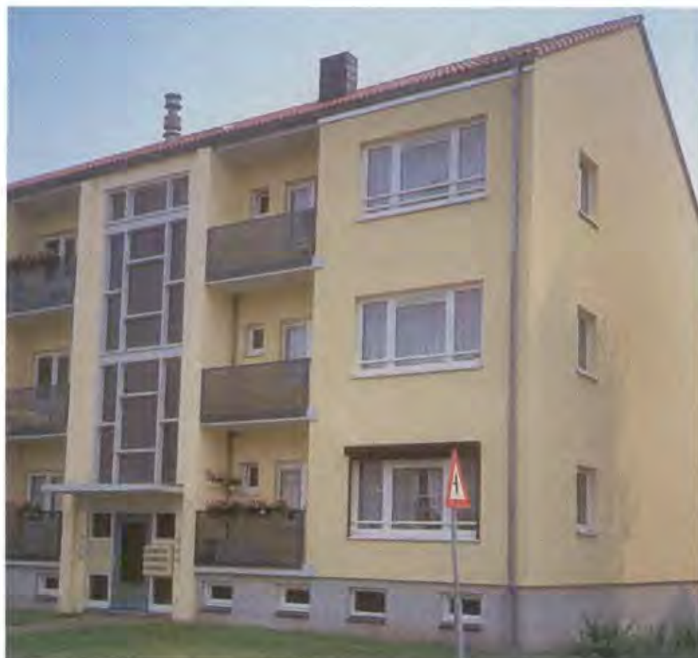
De balkonhekken met een groot wafelmotief van betonnen elementen zijn vervangen door meer eigentijdse geperforeerde staalplaten.
