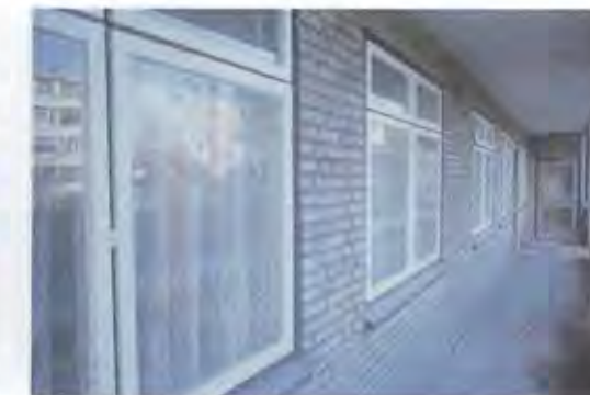
Aan de balkonzijde van het gebouw zijn de balkons dichtgezet met glas zodat er voor de bewoners serres ontstaan.
