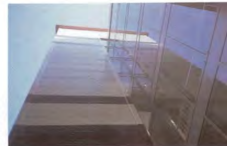
Voor de nieuwe lift werd ook een geheel nieuwe schacht gebouwd. De lift heeft nu op elke verdieping een stopplaats.
