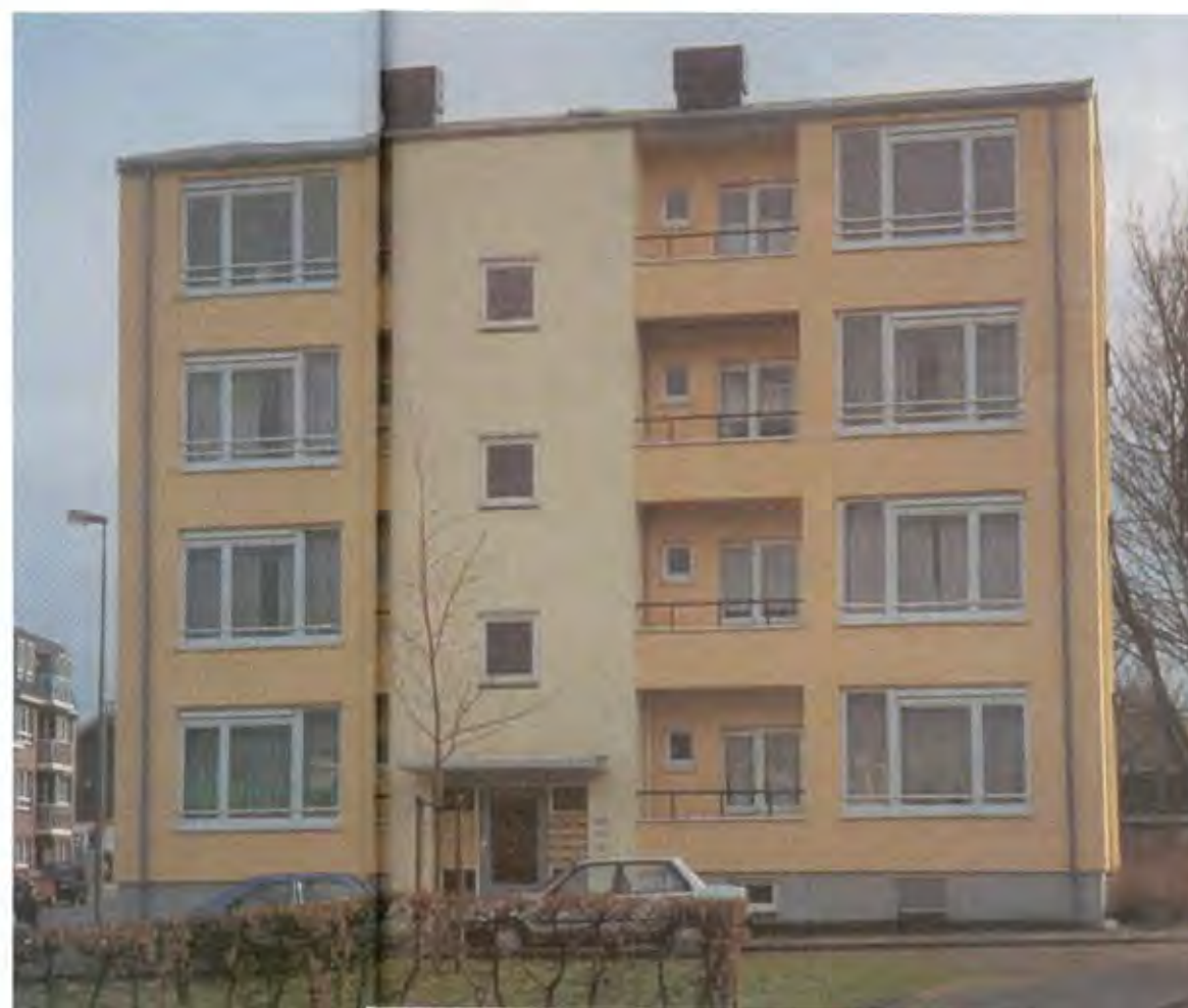
Slecht metselwerk, dichte spouwen en zwakke voegen vormden te veel mankementen om de bestaande buitengevel op te knappen. Om de schades in het metselwerk weg te werken is een buitengevelisolatie aangebracht. Op deze wijze behoren koudebruggen als gevolg van de slechte gevel tot het verleden. Elk gebouw is afgewerkt in een eigen kleur.
