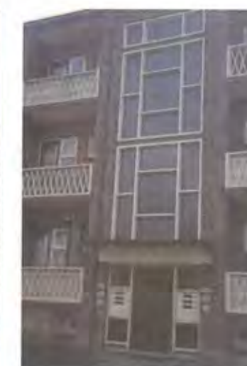
De trappenhuisen en entrees zijn voorzien van nieuwe deuren en de kozijnen zijn waar nodig gerepareerd. De portieken waren vrij toegankelijk maar zijn in de nieuwe situatie afgesloten. Bewoners kunnen de deur nu op afstand openen en alle bezoekers moeten beneden aanbellen. Daarvoor zijn alle postbussen met bel aan een kant van de deur gesitueerd.
