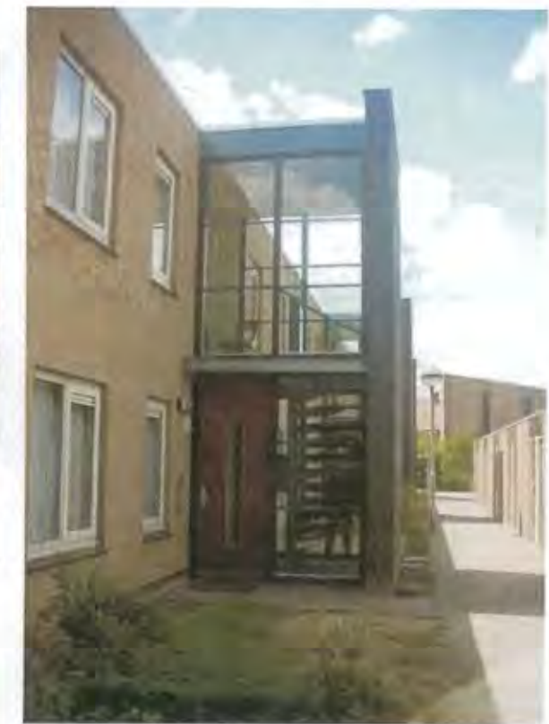
Door de zijwanden van de uitbreiding transparant te houden oogt het trappenhuis heel licht en ruimtelijk, vooral op de hoogste verdieping. Het bellentableau is verplaatst naar de bestaande muur bij de nieuwe entree.
