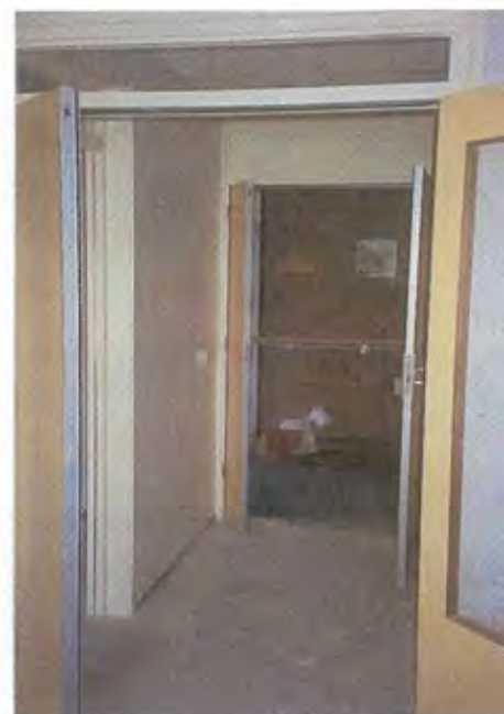
De nieuwe hal kent geen obstakels voor rolstoelers en de elektrische sloten op de deur maken openen vanuit de kamer mogelijk
