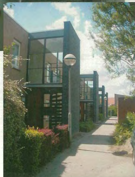
BIJPLAATSEN LIFT IN PORTIEKWONINGEN IN TILBURG
