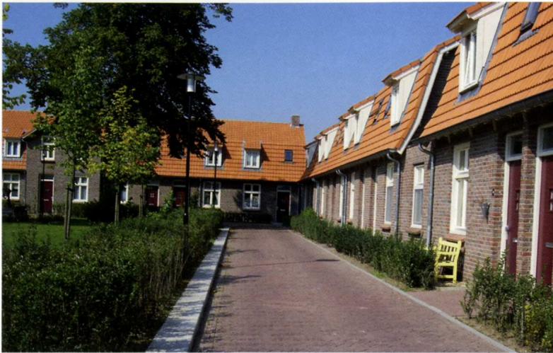
In het renovatieproject Laurentiusplein in het Limburgse Voerendaal zijn maatregelen benoemd om de ongewenste veranderingen uit het verleden te herstellen.
