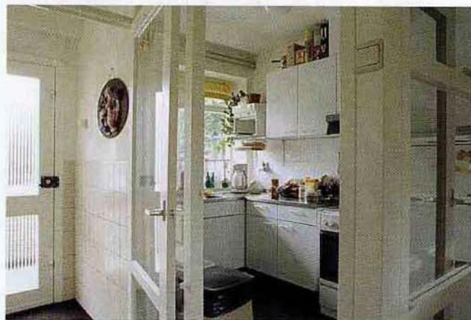
Bij mutatie van bewoners worden de woningen opnieuw ingedeeld, de nieuwe keuken komt in een van de slaapkamers. Voor de afvoer van de riolering zijn er al nieuwe standleidingen aangebracht.
