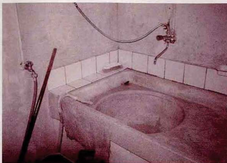
In woningen van vóór 1965 is vaak nog een lavet aanwezig. Het overgrote deel betreft woningen in de sociale huursector. Hiervan zullen er de komende tijd zo'n 40.000 per jaar worden vernieuwd.
