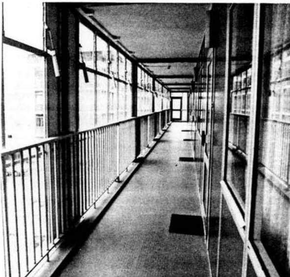
Ouderencomplex in Amstenrade: dichtgezette galerijen
